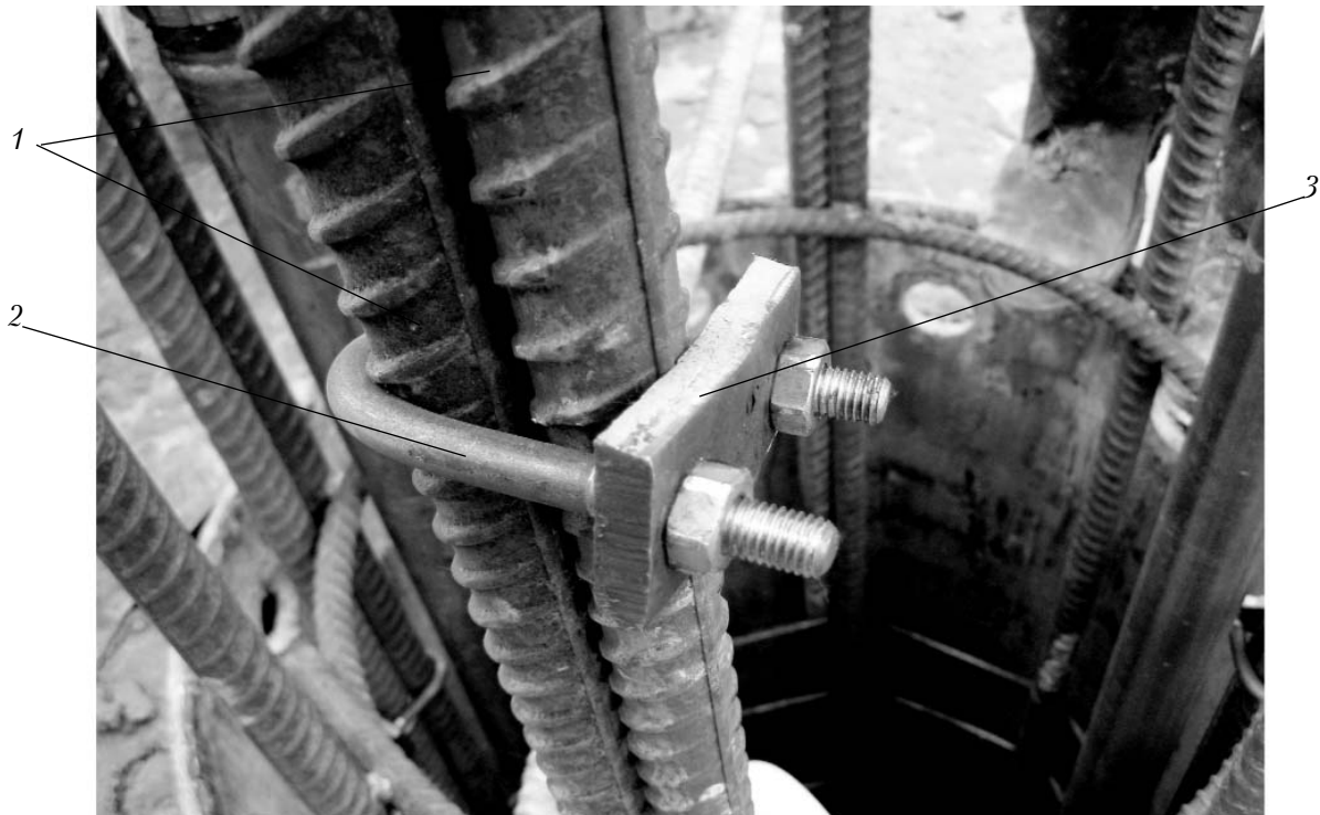
Рис. 7. З'єднуючий арматурні стрижні металевий хомут:
