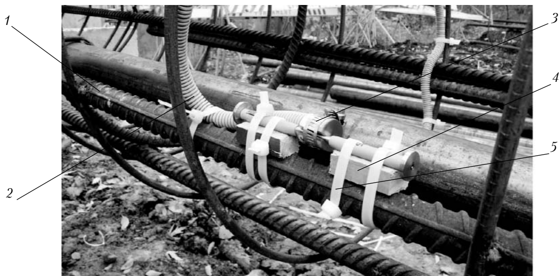
Рис. 5. Закріплені на армокаркасі контрольної палі датчик Geokon 4200: 1 – арматурний каркас контрольної палі, 2 – гофрована труба, 3 – датчик Geokon 4200, 4 – дерев'яна підкладка, 5 – нейлоновий хомут
